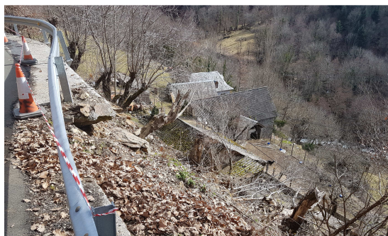
Imatge 03. Estat actual carretera de Canejan.
