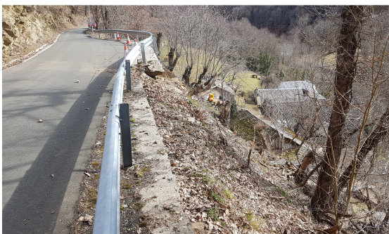
Imatge 02. Estat actual carretera de Canejan.
